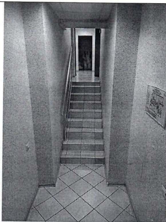
Фото №10 «Лестница внутри здания»
